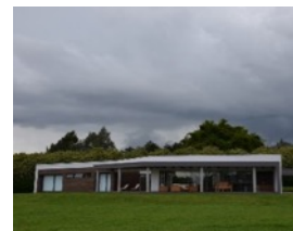
CASA AO Ubicación: Rionegro Entrega: 31/07/14 Área construida: 445 m 2
