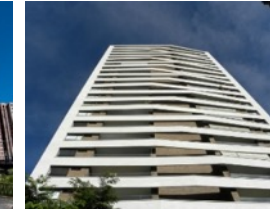
EDIFICIO MONTES Ubicación: Medellín Entrega: 12/05/15 Área construida: 13.883 m 2
