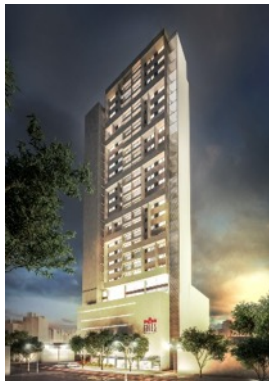
EDIFICIO GALES Ubicación: Bello Entrega: 8/08/17 Área construida: 18.514 m 2
