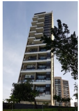
EDIFICIO ART LIVING Ubicación: Medellín Entrega: 9/08/18 Área construida: 13.039 m 2
