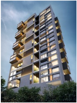
EDIFICIO CANTIERE Ubicación: Medellín Entrega: En proceso Área construida: 8.809 m 2
