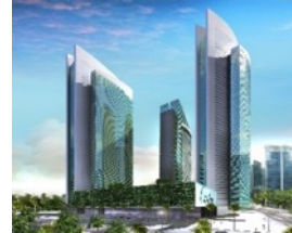
CENTRAL PARK PANAMÁ Ubicación: Panamá Entrega: 2007 Área construida: 393.598 m 2
