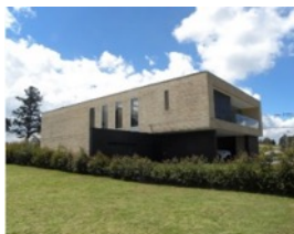
CASA RM Ubicación: Envigado Entrega: 14/10/15 Área construida: 580 m 2
