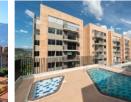
RESERVA DEL PRADO Ubicación: San Antonio Prado Entrega: 1/08/17 Área construida: 9.468 m 2
