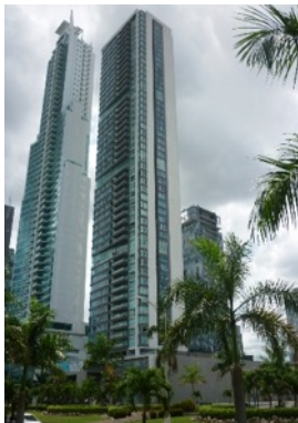
ALTAMAR DEL ESTE Ubicación: Panamá Entrega: 2006 Área construida: 36.007 m 2
